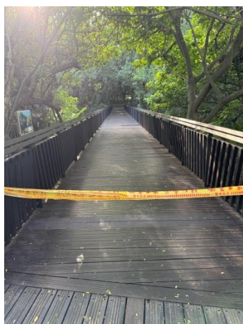
▲ 園區木棧道護木漆作業
