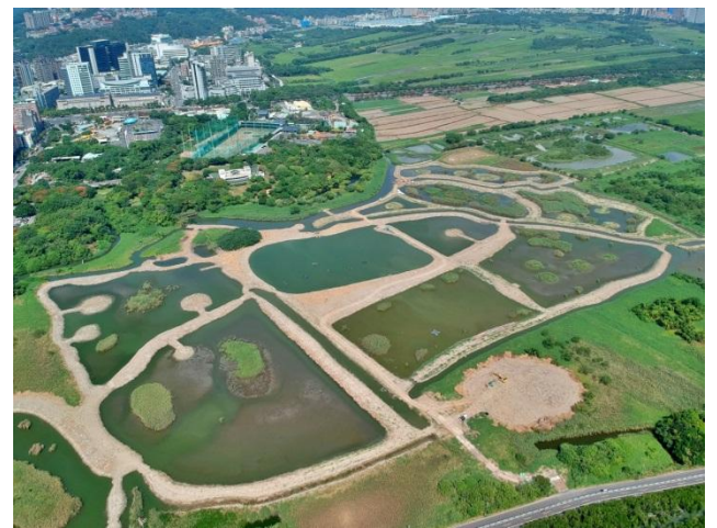
▲完成棲地復育工程
